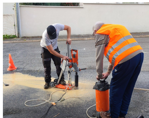
Pose des potelets de sécurité
