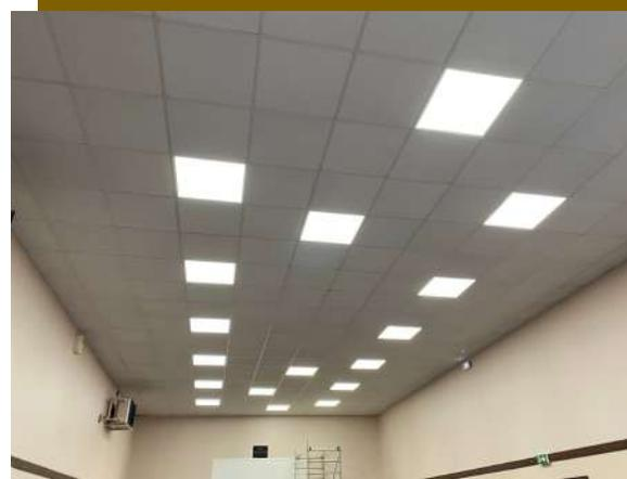
Il convenait donc de doter ces deux bâtiments d'un **éclairage moderne et efficace**. Nous avons ainsi opté pour un éclairage led. Adieu les vieilles dalles néons et les projecteurs halogènes. Le passage en tout led promet **une économie de 50% sur la consommation électrique**.
