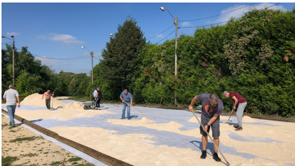
24 septembre 2021 - Fin d'installation du terrain de pétanque par les boulistes Pencharçais
